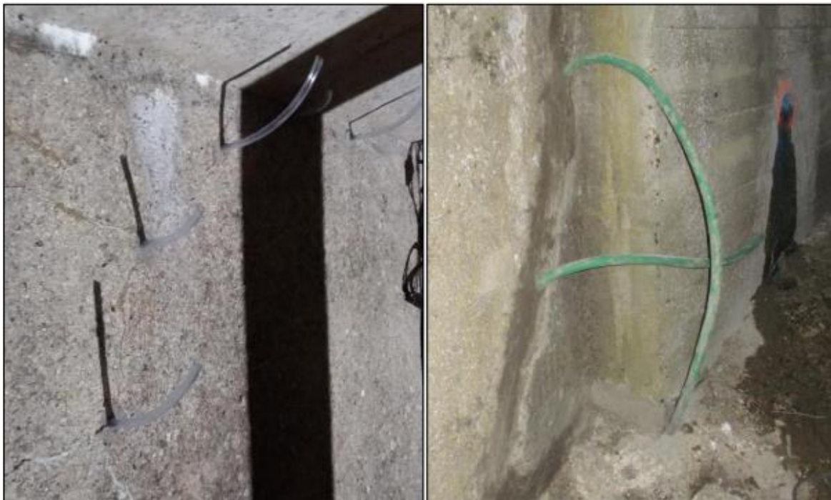
Figure 8 : Ligne 325 000 – PRa pk 144+388 – Exemple de mise en place de canule d'injection
