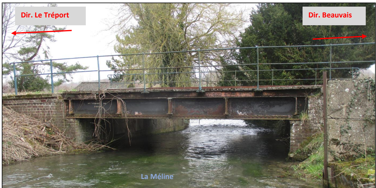
Figure 3 : Ligne 325 000 - Élévation gauche de l'ouvrage situé au PK 144+388
