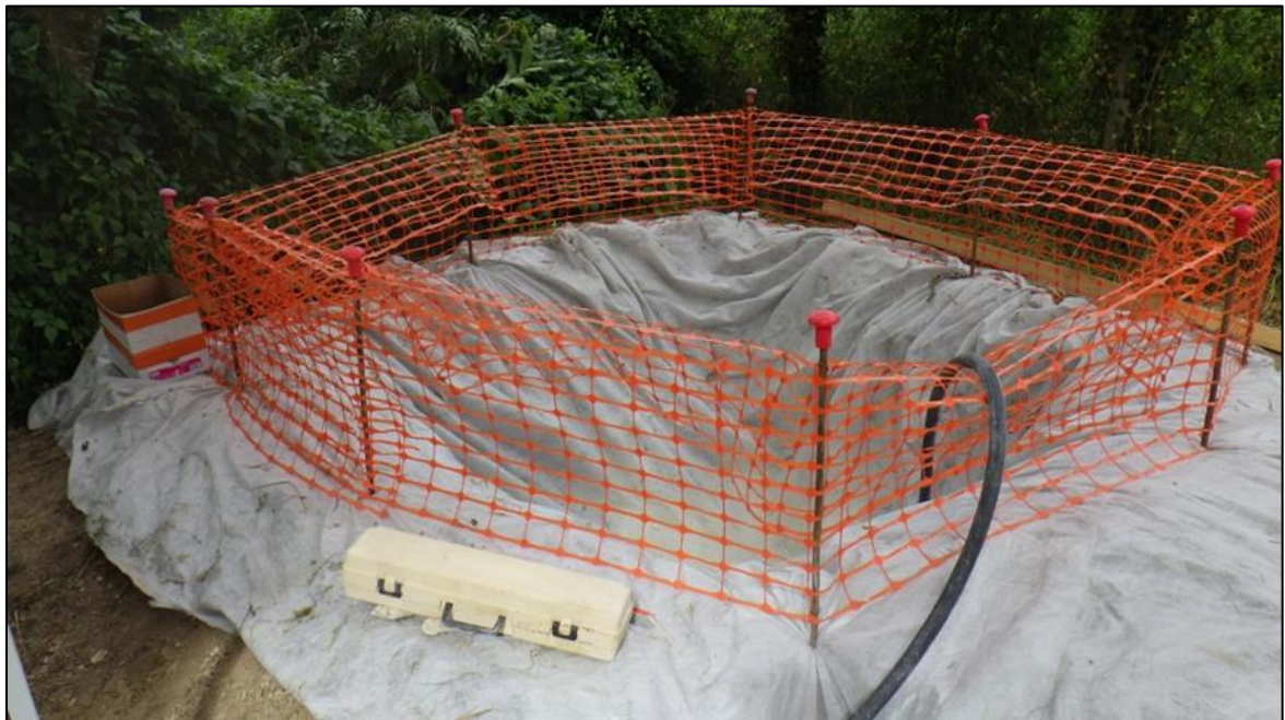
Figure 10 : Exemple d'un bassin de décantation provisoire pour les eaux d'exhaure de batardeaux
